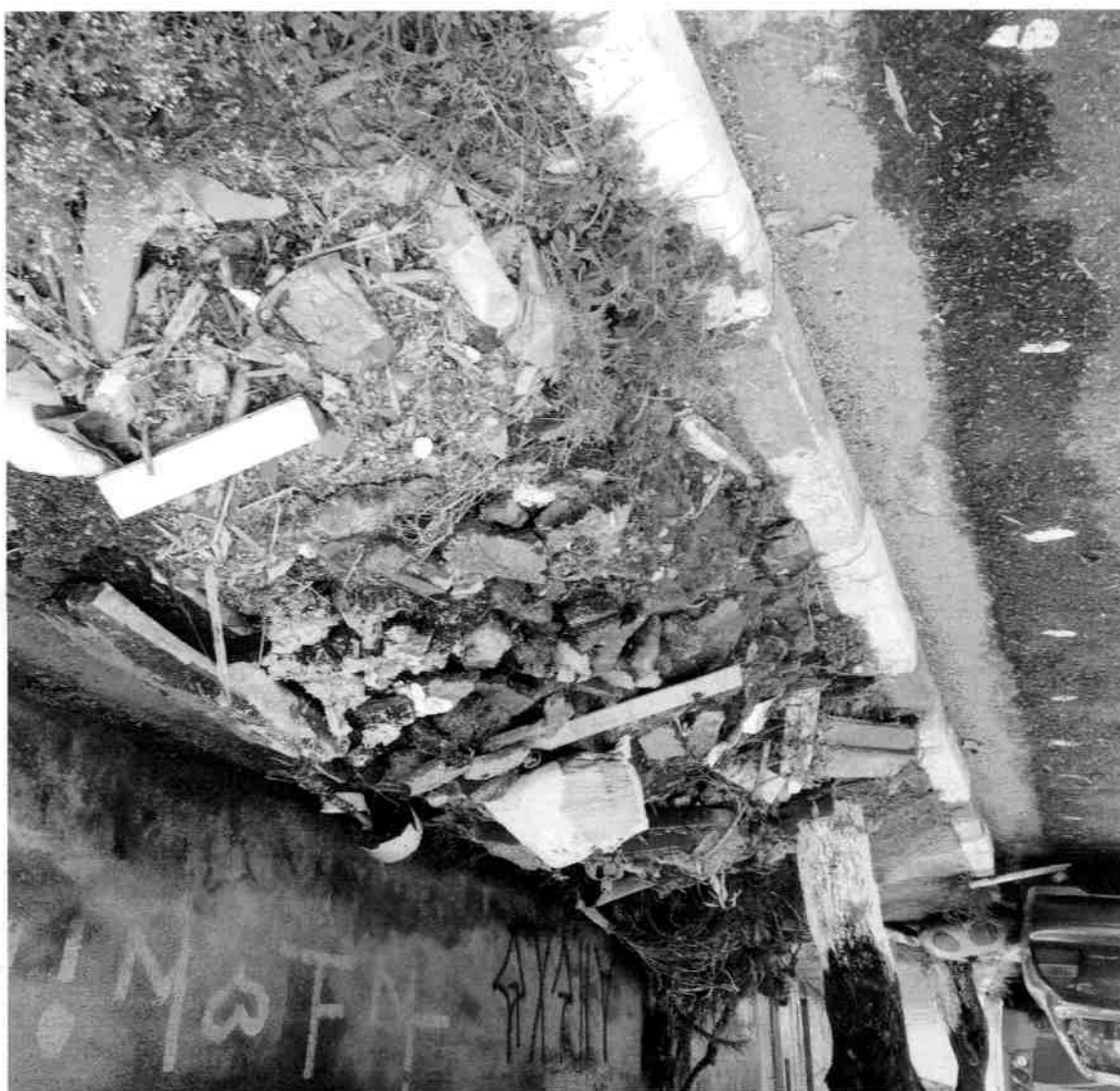
LIMPEZA E RETIRADA DE ENTULHOS DA CONSTRUÇÃO CIVIL NA RUA DR. ROBERTO NABUO SATO, EM FRENTE AO Nº 180, VILA CINTRA - MOGI DAS CRUZES.
